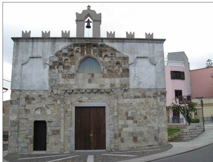
Fig. 10. Guspini, chiesa di Santa Maria, facciata (foto C. Nonne).
