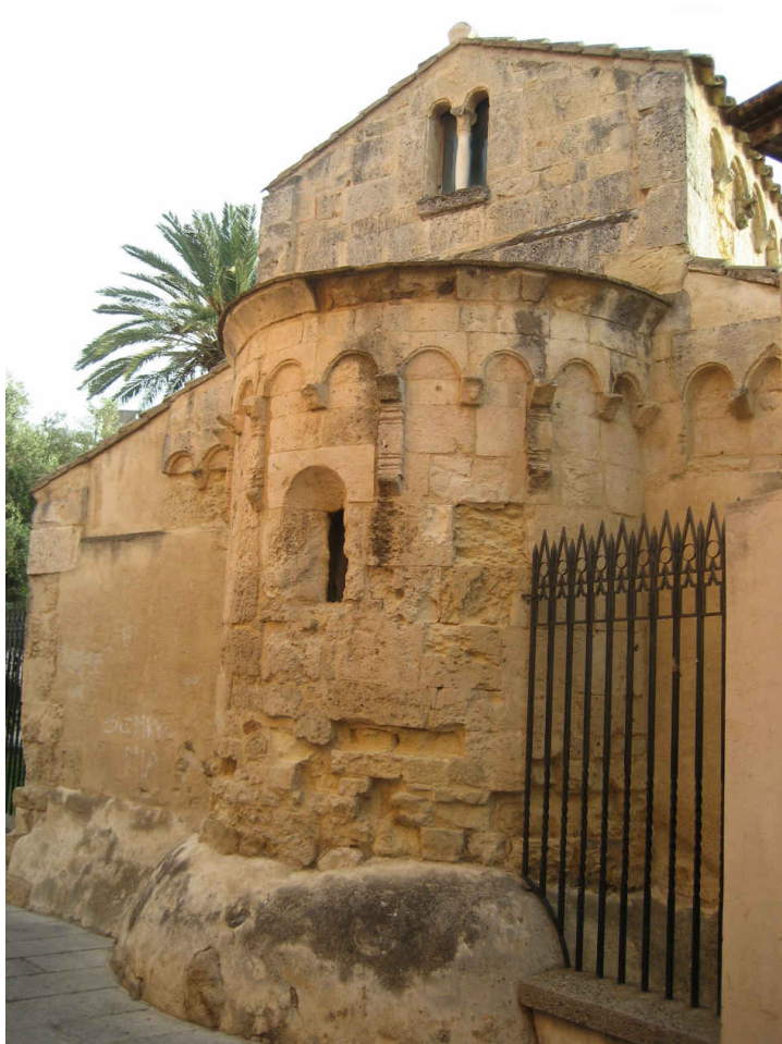
Fig. 11. Selargius, chiesa di San Giuliano, prospetto absidale (foto C. Nonne).
