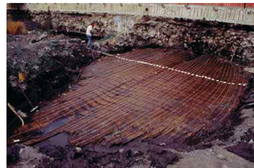
Scavi sotto il manto stradale.
